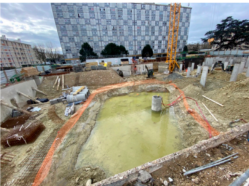
Pollution des sols et de la nappe en HCT (hydrocarbures totaux) à Sarcelles (Val d'Oise) ; ancien garage automobile / futurs logements collectifs : dépollution par excavation et évacuation des sols, pompage/écrémage de la nappe.
