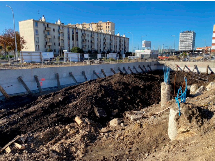
Pollution des sols et de la nappe en HCT (hydrocarbures totaux) à Sarcelles (Val d'Oise) ; ancien garage automobile / futurs logements collectifs : dépollution par excavation et évacuation des sols, pompage/écrémage de la nappe.
