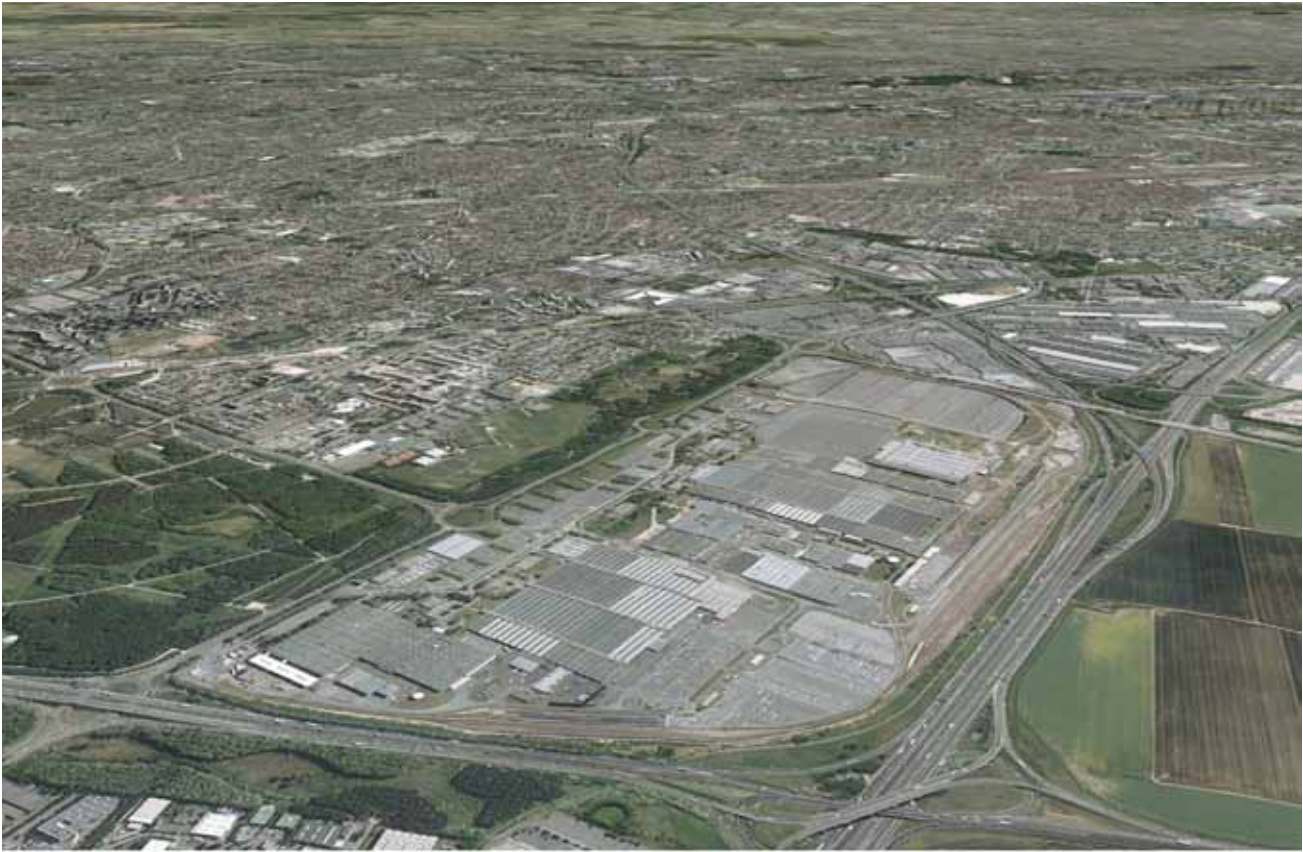
Figure 7. Vue aérienne nord Aulnay
