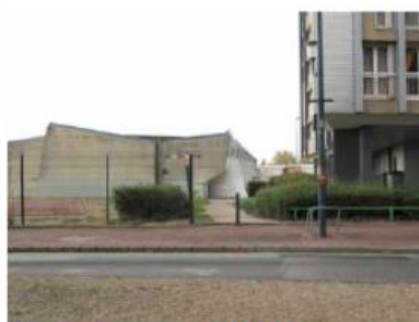
Le gymnase Lemarchand depuis la rue Henri Dunant
