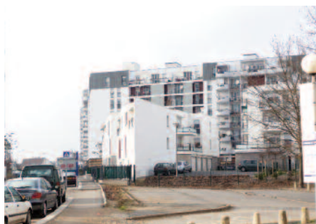
Les nouveaux logements et les anciens résidentialisés
