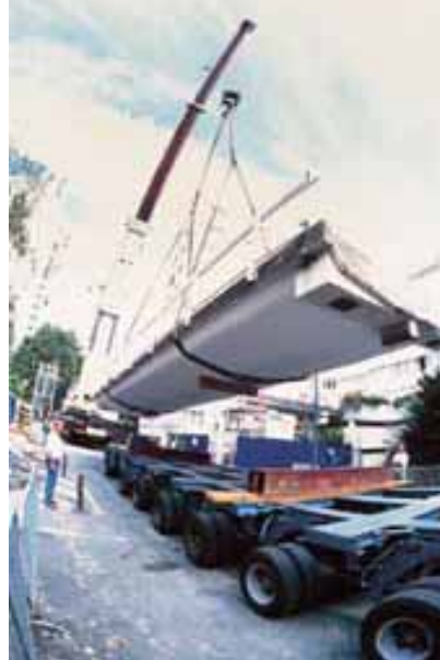
Épinay, démolition des passerelles du centre-ville
